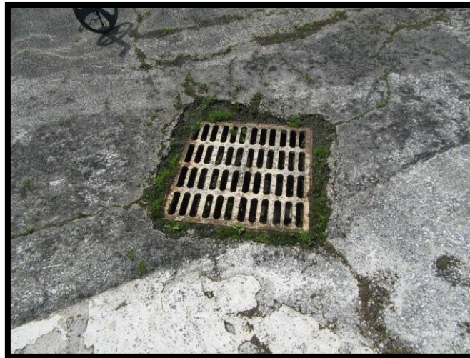
Figure 3 : Photographie de la surface de la plateforme, un avaloir est visible
