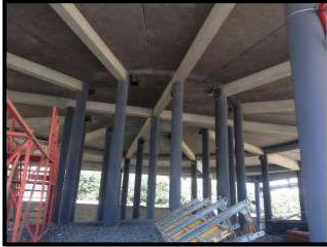
Figure 2: Photographie de la structure poteau poutre de la plateforme
